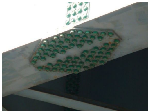
写真 2.4.2 下フランジに設けた落下防止キャップ
