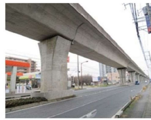
図 2.7 土浦高架橋(橋長 1,614m)
