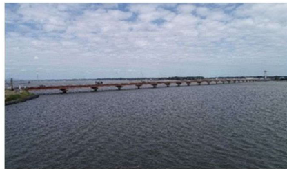
図 2.6 霞ヶ浦大橋(橋長 1,015m)
