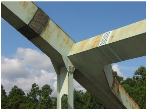
写真 2.4.1 桁ウェブに設けた落下防止ネット
