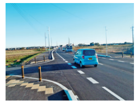
開通した井野工区
