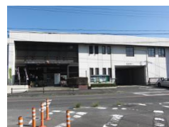
建物正面（現況）
