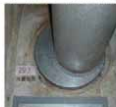
貫通部の止水処置(例)
