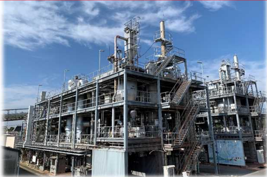
汚泥焼却炉（霞ヶ浦浄化センター）
